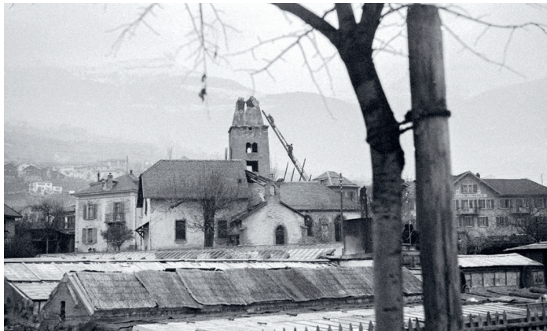
Église Notre-Dame des Marais à Sierre, après le tremblement de terre du 25 janvier 1946. (Photo Samuel Aegerter, MV-Martigny)
