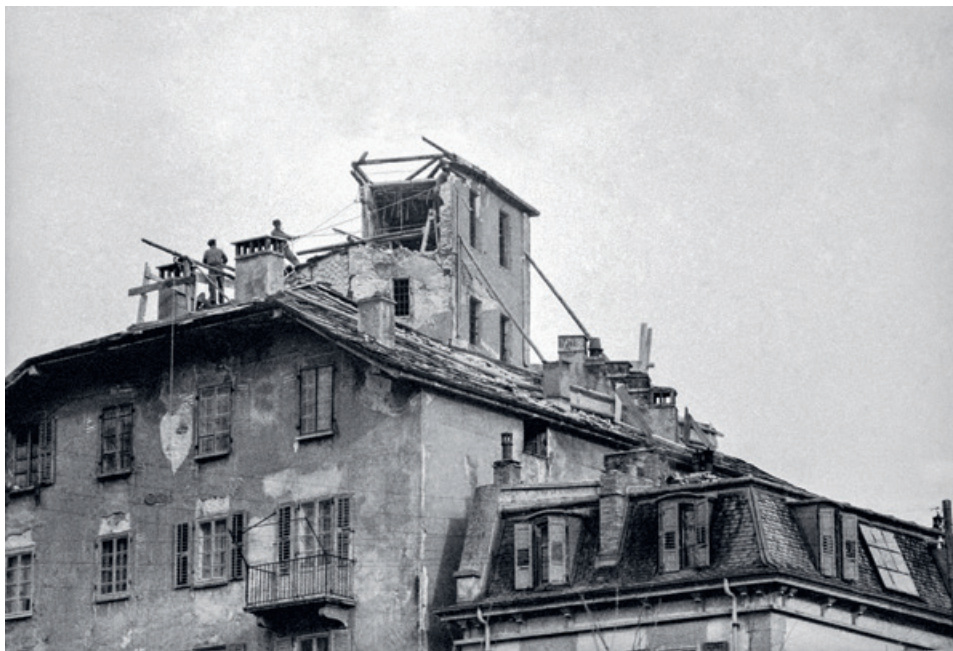
Dégâts dans la ville de Sion.
