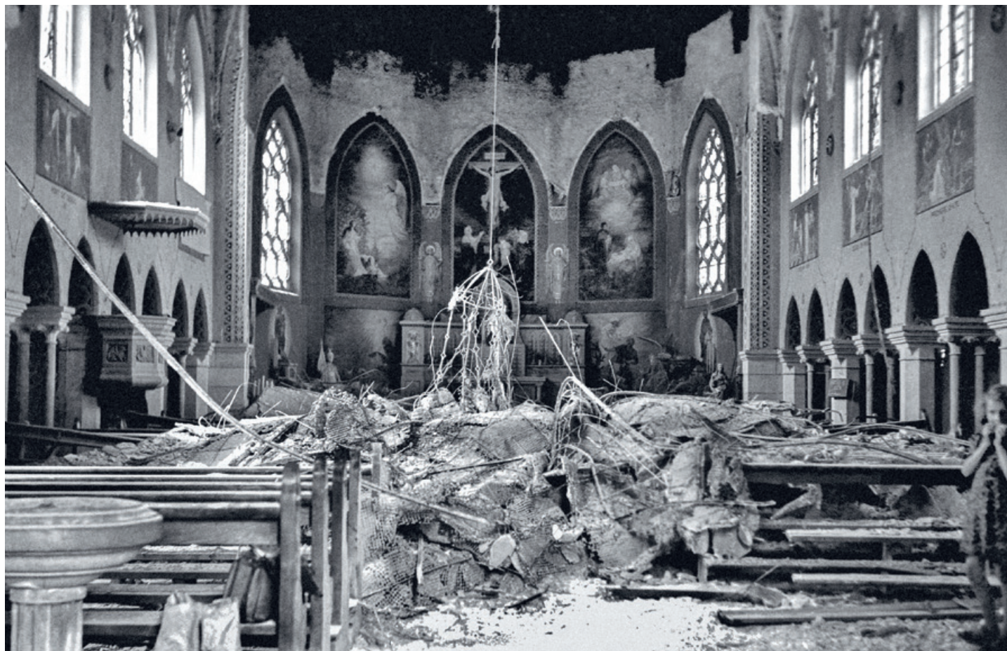
Effondrement de la voûte de l'église de Chippis, à la suite de la réplique du 30 mai 1946.
