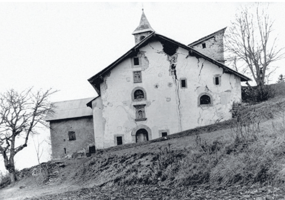
La chapelle de Crételles à Randogne présente de gros dégâts; elle devra être démolie. (Photo Charles Paris, MV-Martigny)
